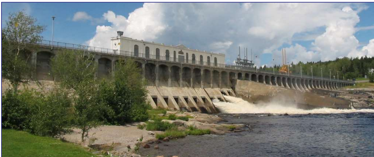
Barrage de Portage-des-Roches (X0000899)
