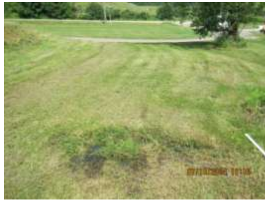
Figure 4 Résurgence sur le champ d'épuration
