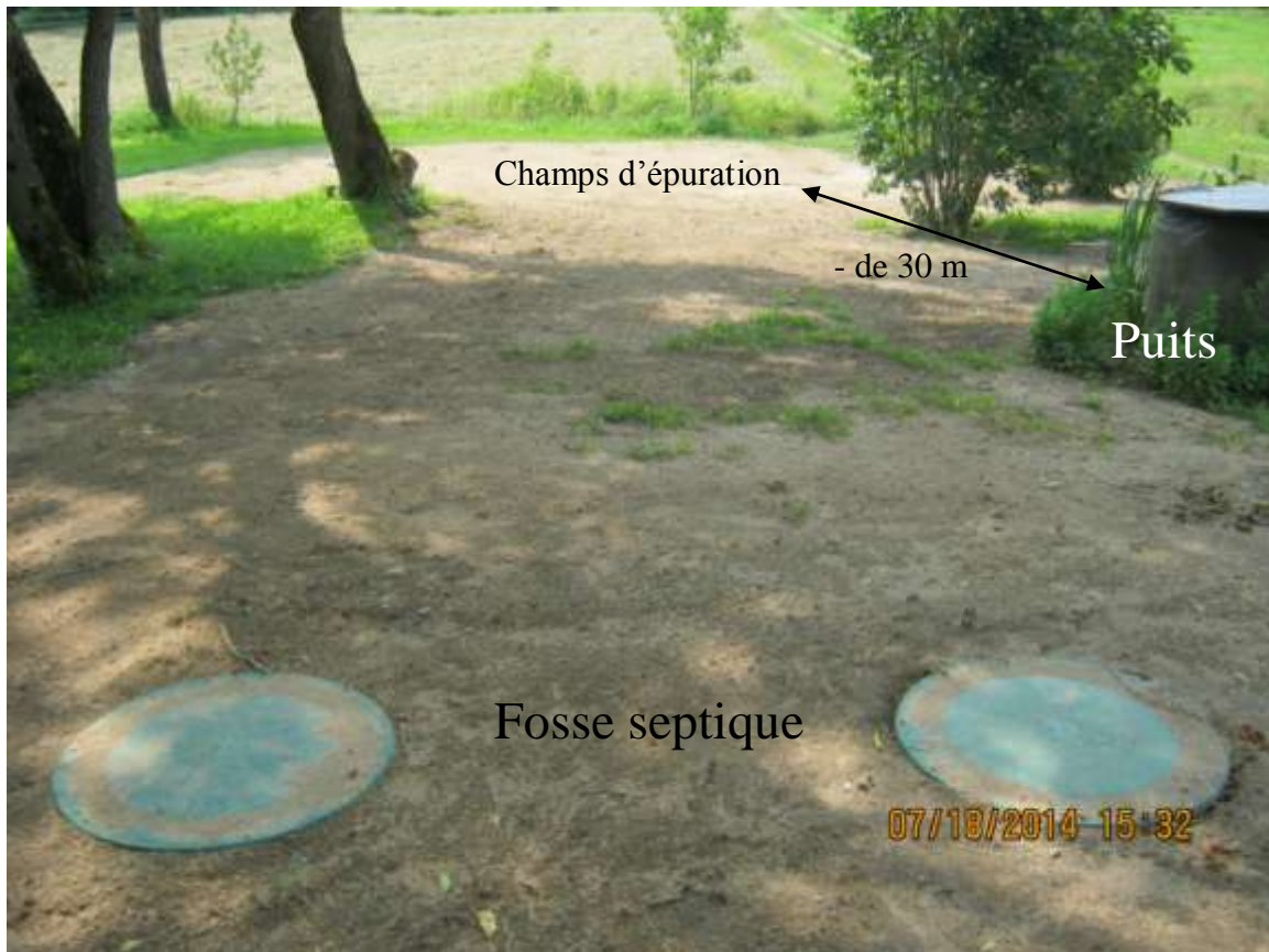
Figure 5 : Distance inadéquate entre le puits et l'installation septique
