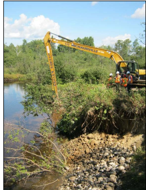
Travaux du projet de restauration des frayères du ruisseau Jourdain
