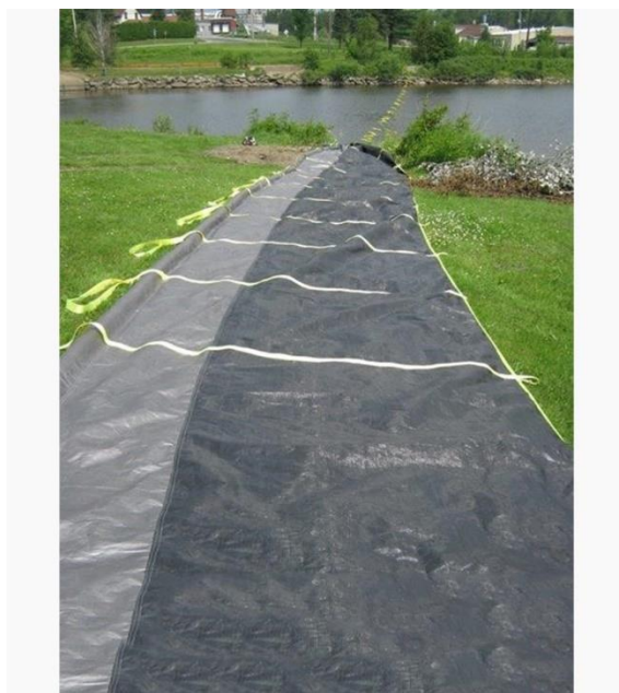
Figure 9: Exemple de barrière à sédiments hors de l'eau (photo : Soleno)
