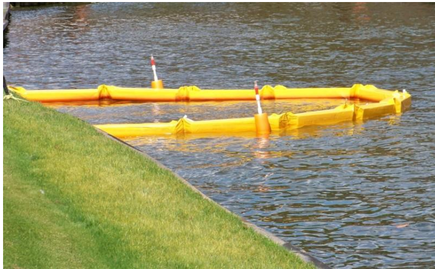
Figure 8: Exemple de barrière à sédiments installée dans un plan d'eau (photo : Soleno)
